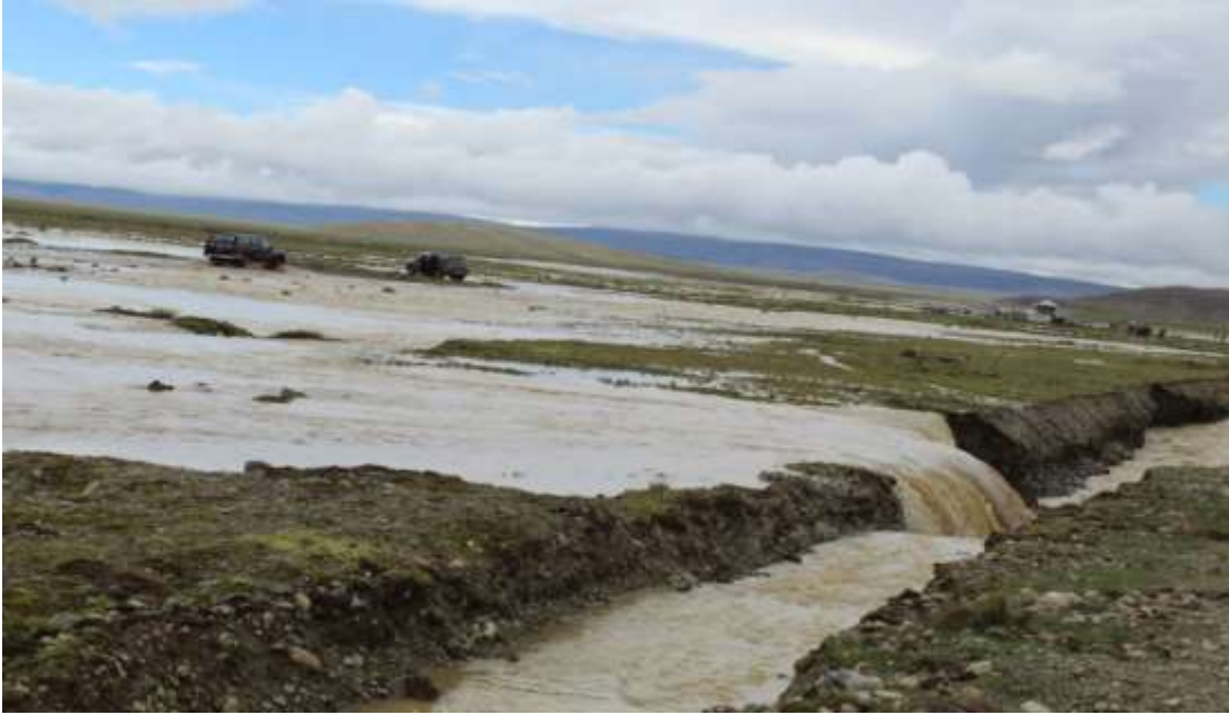
FOTO N° 04: DESBORDE DEL RIO SUCCHES AFECTANDO CULTIVOS Y VIAS DE COMUNICACIÓN EN HUANCANE.
